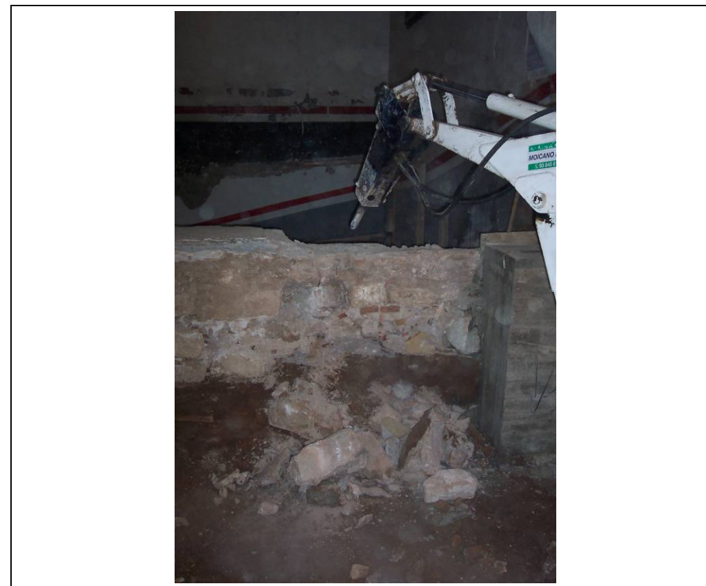
Foto 195: Àmbit 6. Desmuntatge del mur 1028
