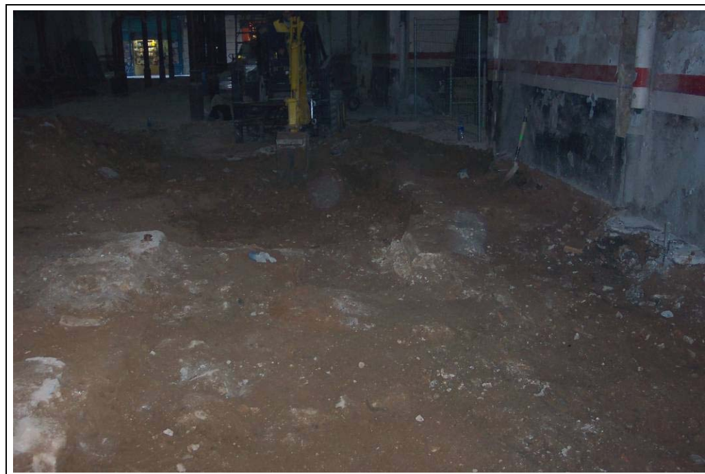
Foto 5: Sector 1. Inicial després del rebaix mecànic. Fotografia realitzada mirant al carrer Banys Nous
