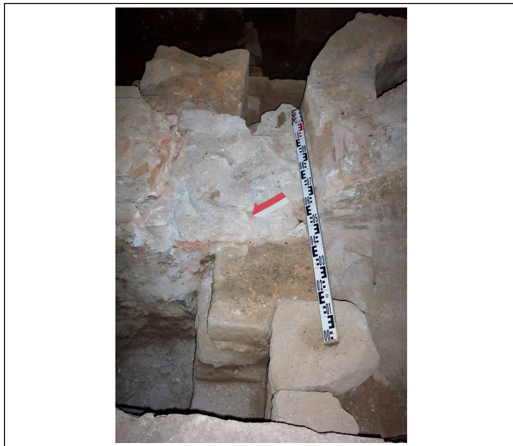
Foto 114: Àmbit 6. Desmuntatge parcial de la riostra 1052
