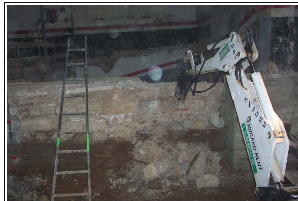
Foto 196: Àmbit 6. Desmuntatge del mur 1028
