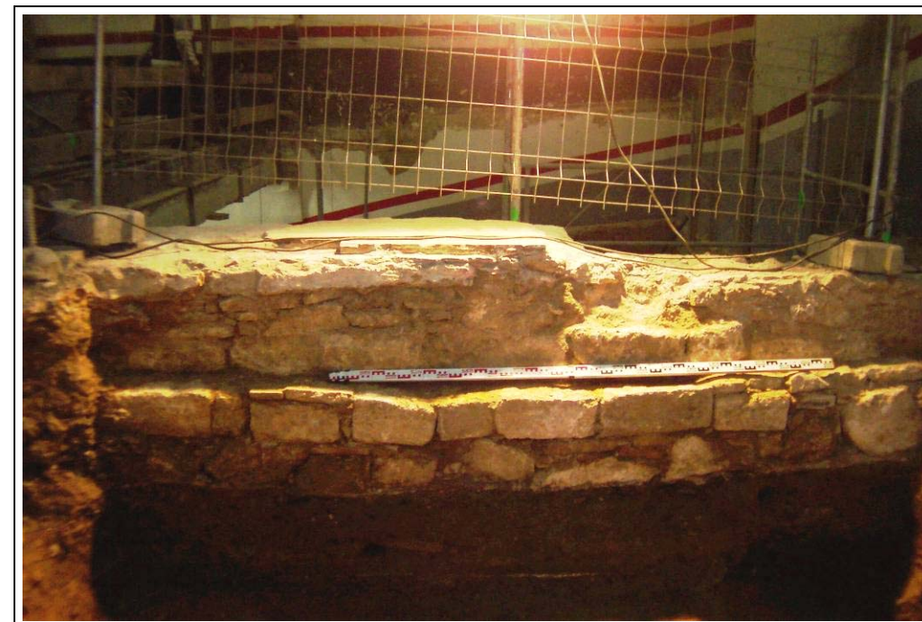
Foto 112: Àmbit 6. Alçat del mur 1028
