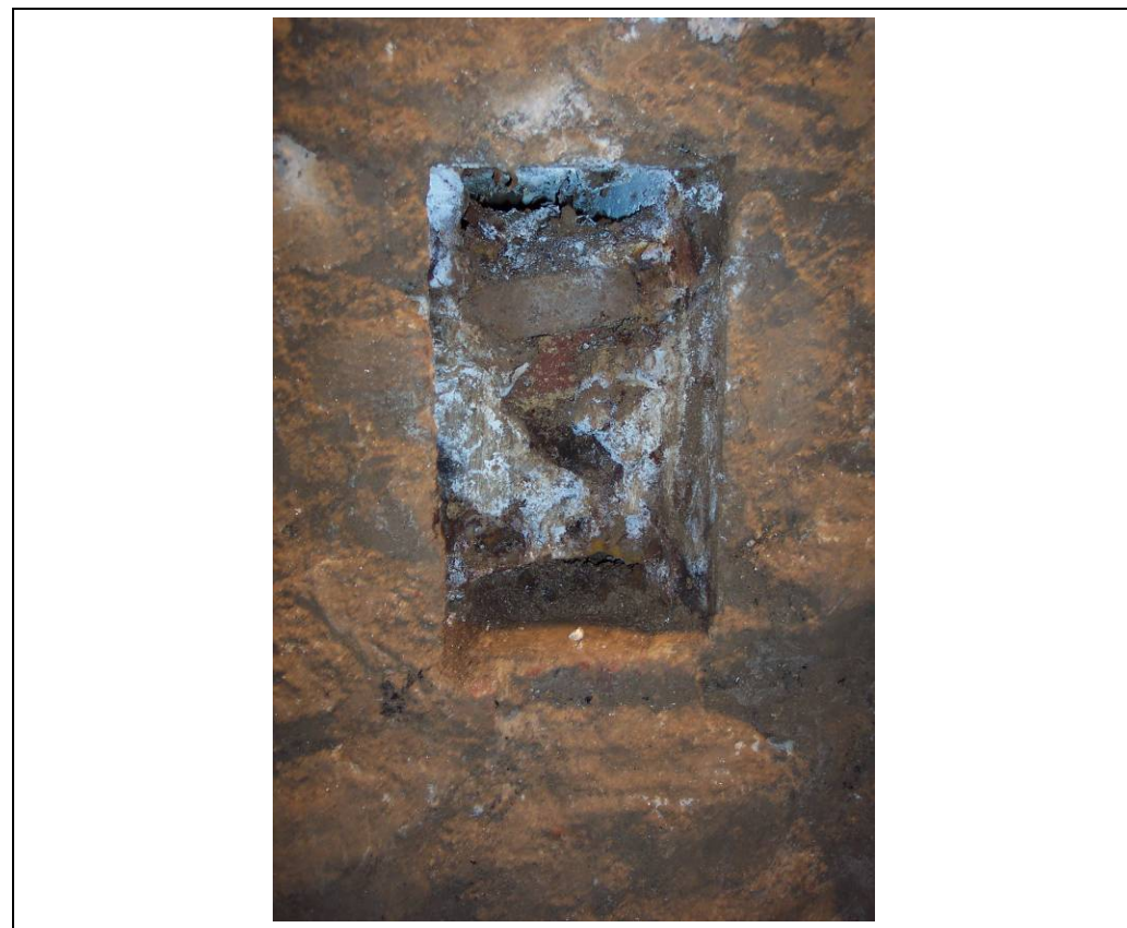
Foto 173: Àmbit 6. Detall d'un encaix
