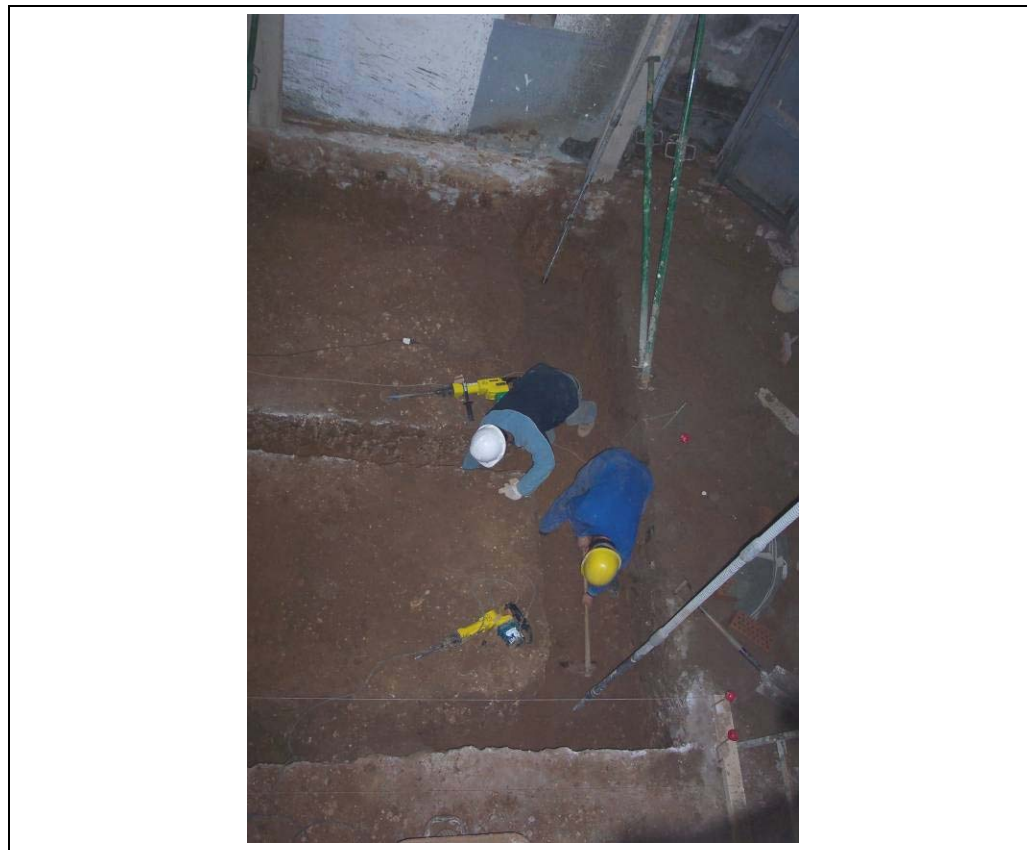
Foto 218: Excavació manual de les riestres un cop assolit el substrat geològic
