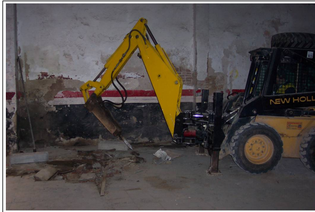
Foto 2: Inici dels treballs de demolició del paviment
