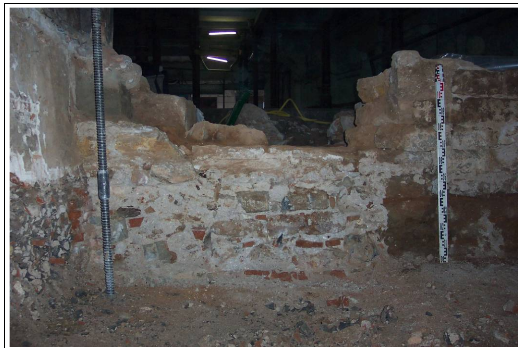
Foto 194: Àmbit 5 després del desmuntatge del dipòsit 1158
