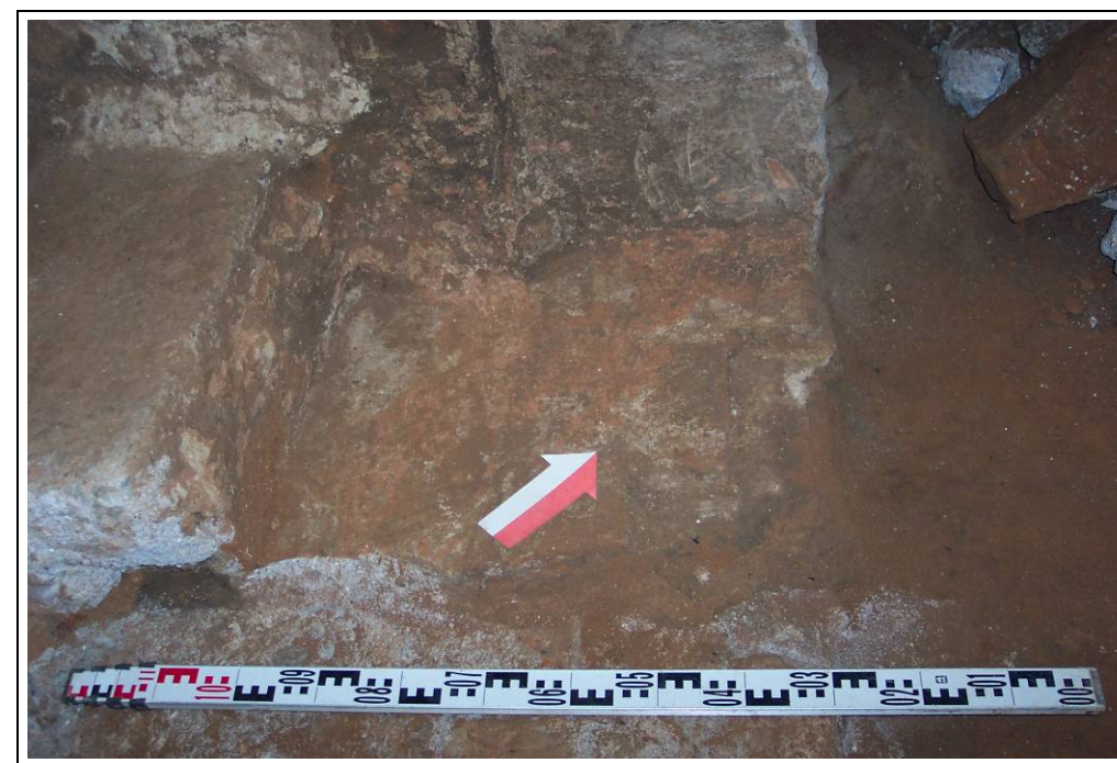
Foto 159: Àmbit 6. Detall del morter hidràulic del dipòsit
