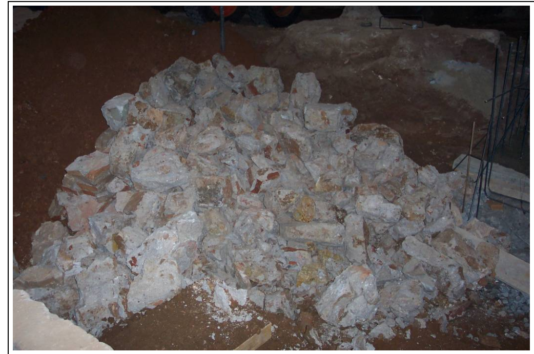
Foto 183: Àmbit 6. Desmuntatge del mur 1052
