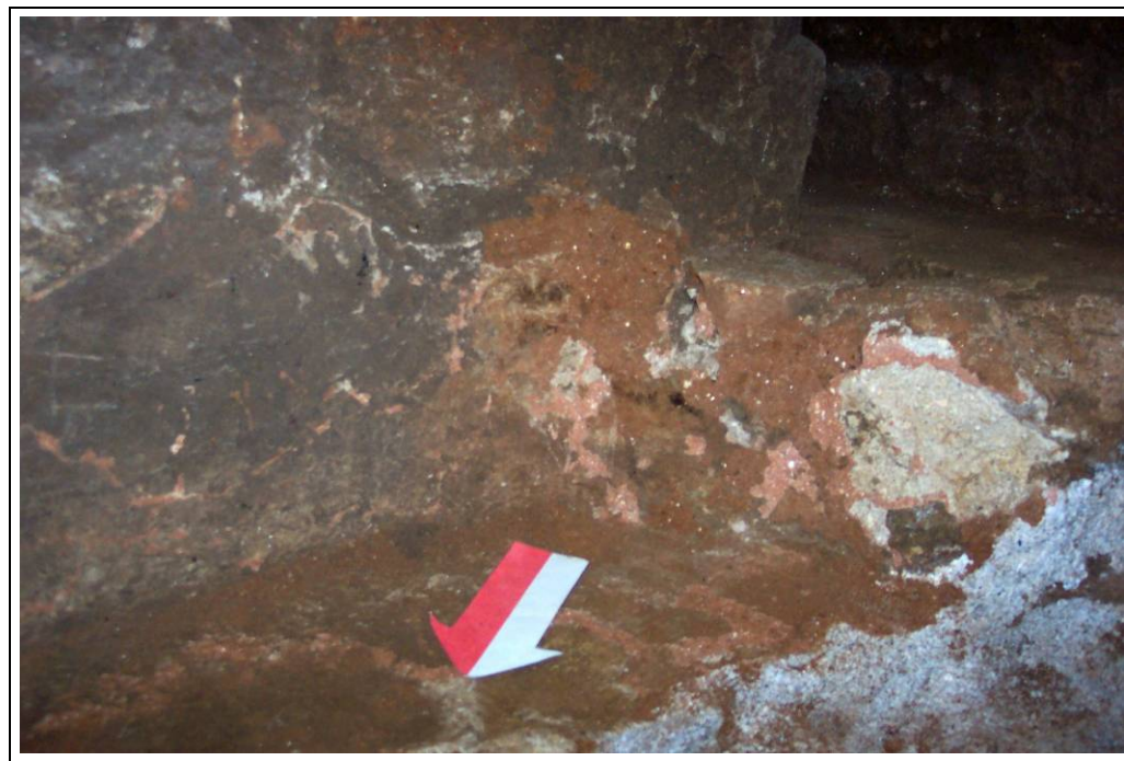
Foto 158: Àmbit 6. Detall del morter hidràulic del dipòsit
