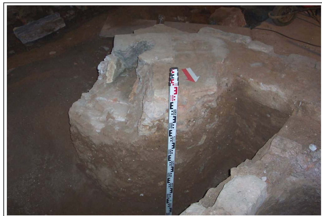
Foto 66: Àmbit 6. Fonamentació de pilar 1074
