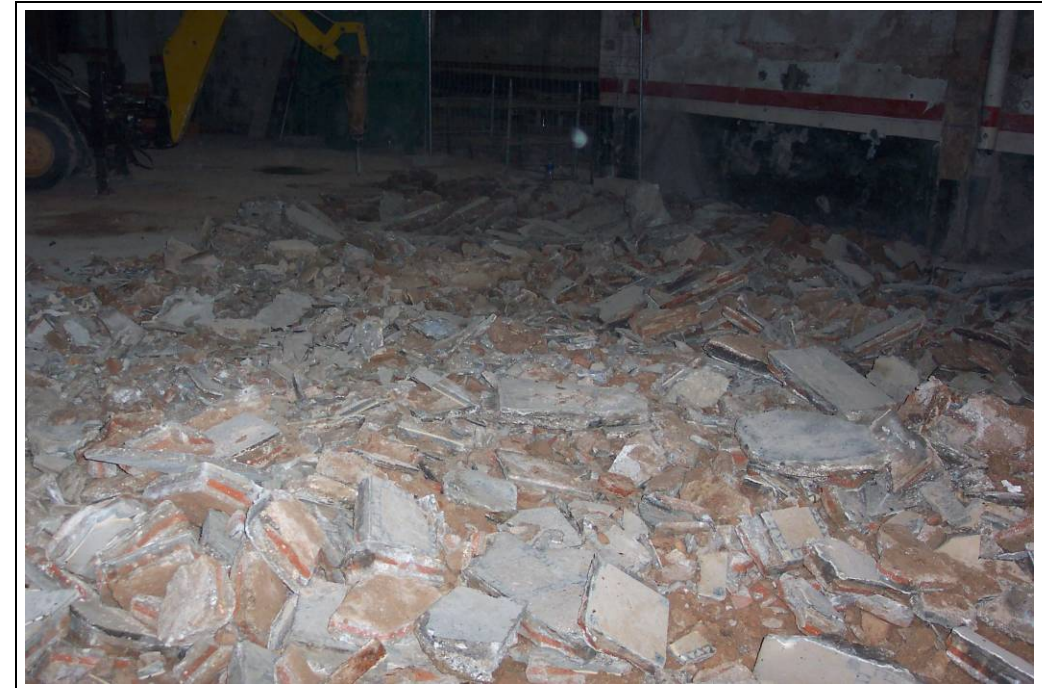
Foto 3: Demolició del paviment contemporani
