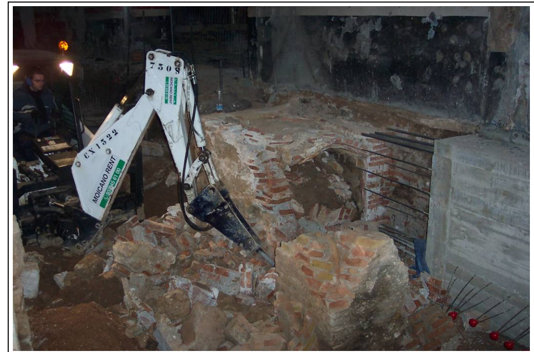
Foto 184: Àmbit 1. Desmuntatge de la claveguera 1025
