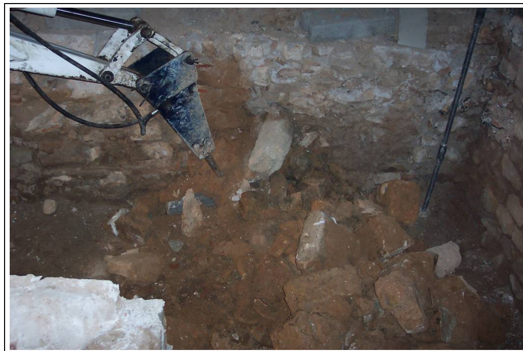
Foto 186: Àmbit 1. Desmuntatge del mur 1166
