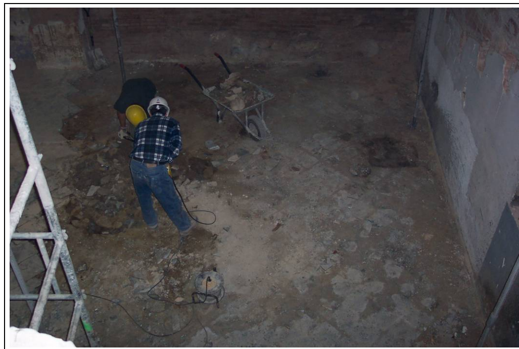
Foto 6: Sector 2. Tasques d'extracció del paviment
