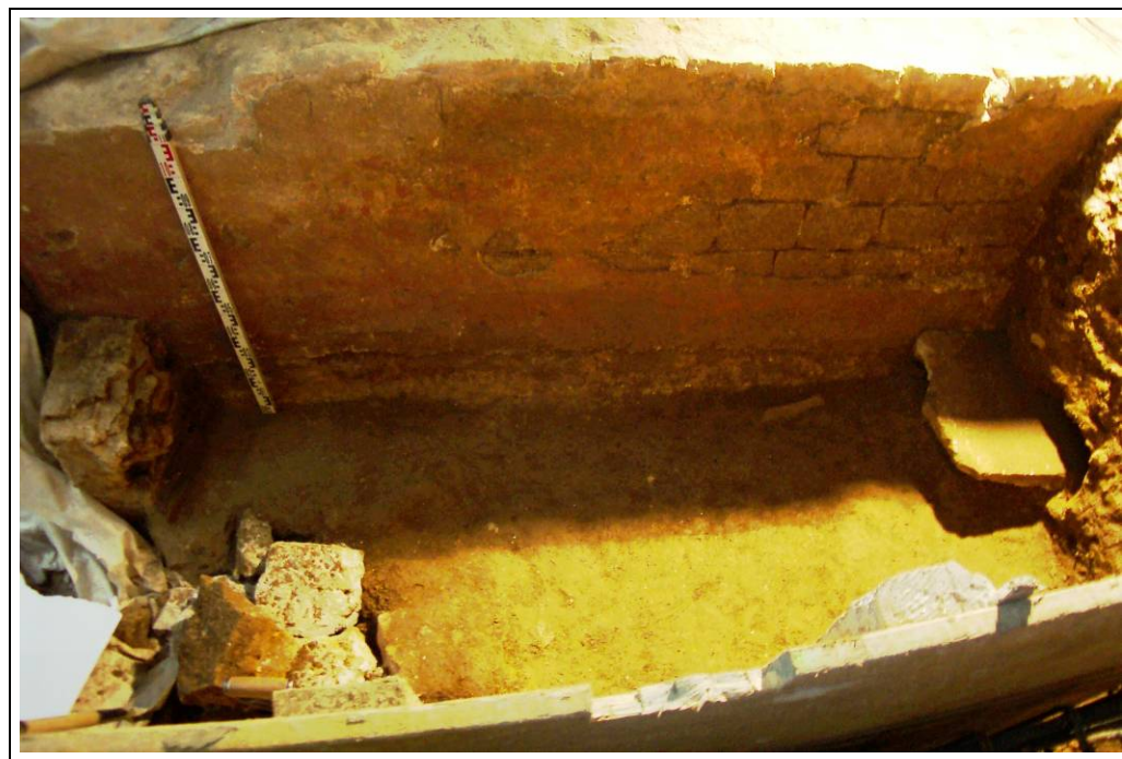
Foto 149: Àmbit 6. Alçat del mur 1054
