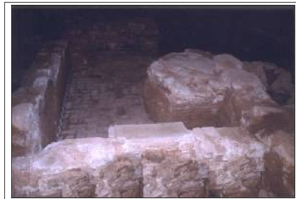
Foto 20: Àmbit 3. General amb mur 1031 i paviment afectat per la fonamentació de pilar 1035
