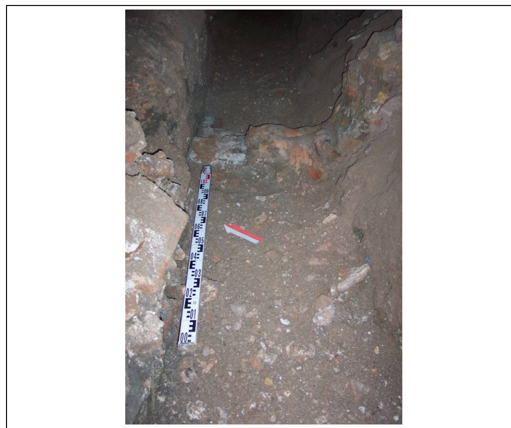
Foto 235: Rasa del col·lector general de la finca UE 3022
