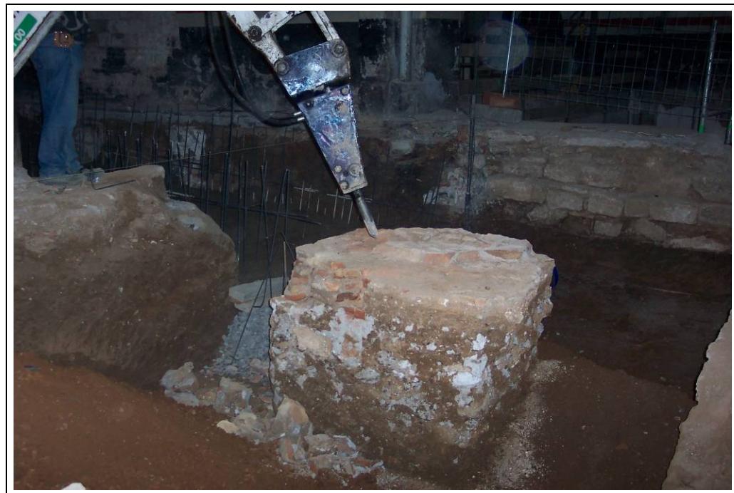
Foto 182: Àmbit 6. Desmuntatge del pilar 1057
