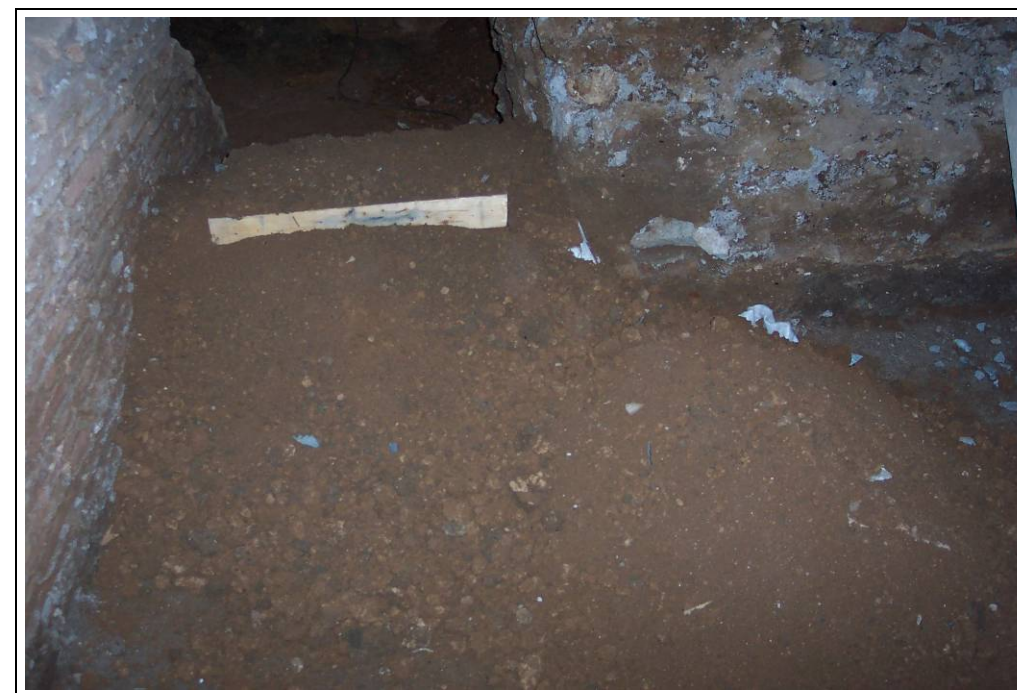
Foto 179: Àmbit 6. Cobriment amb geotèxtil i terra dels murs 1147 i 1148
