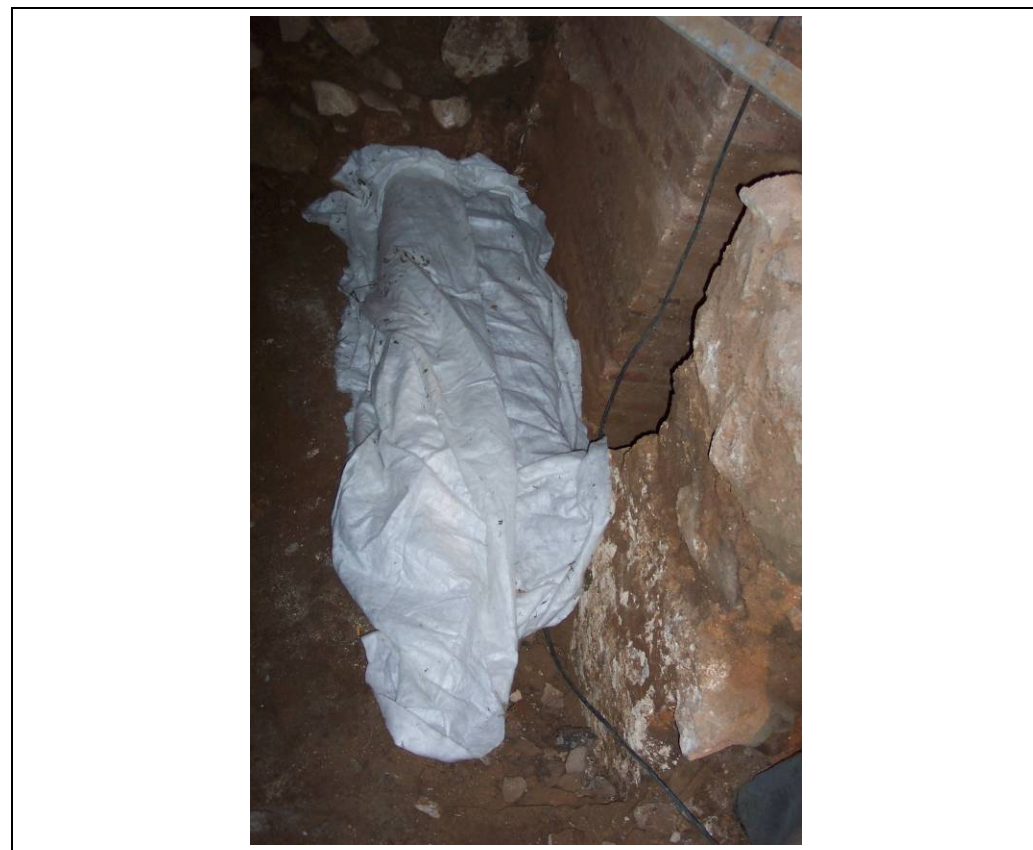
Foto 177: Àmbit 1. Cobriment amb geotèxtil del mur 1155
