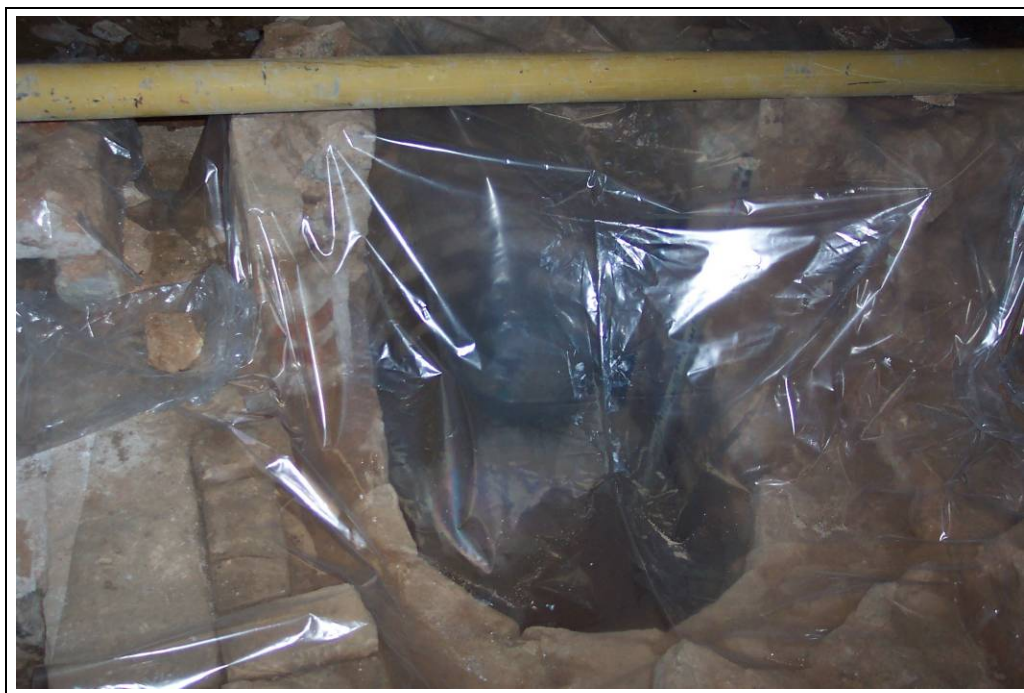
Foto 189: Àmbit 6. Cobriment del pou durant les tasques de realització de les riestres
