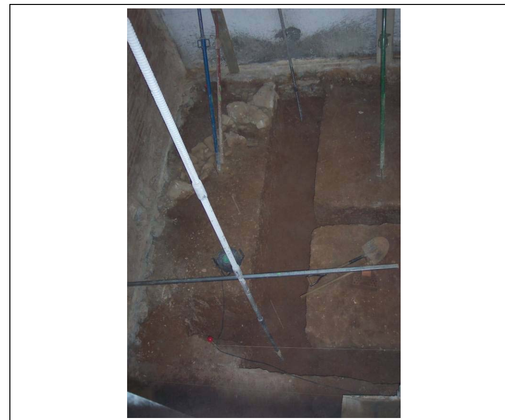
Foto 220: Excavació definitiva de les riestres del projecte en el sector 2
