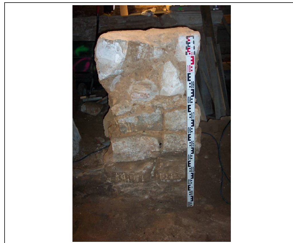
Foto 111: Àmbit 3. Fases del mur 1018 i 1118
