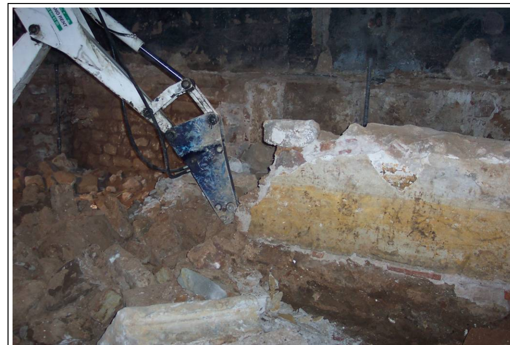
Foto 187: Àmbits 3 i 5. Desmuntatge del mur 1034
