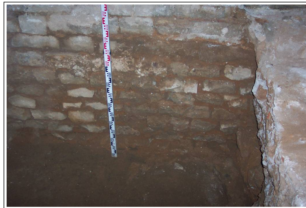
Foto 103: Àmbit 4. Alçat del mur 1039
