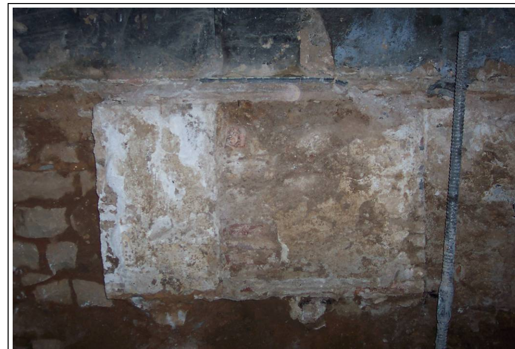
Foto 188: Àmbit 5. Detall de la fase moderna del mur divisor de finca 1191 superposat a 1039
