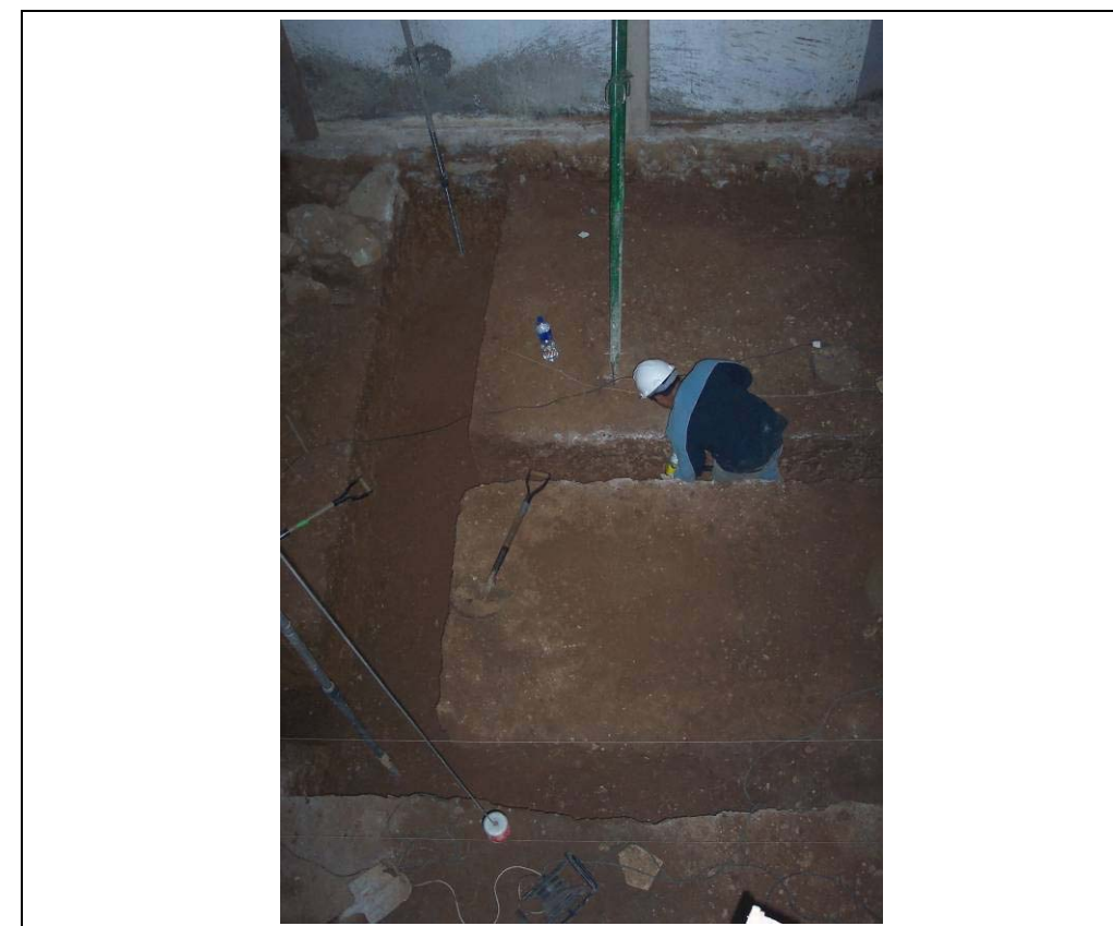
Foto 219: Excavació manual de les riestres un cop assolit el substrat geològic
