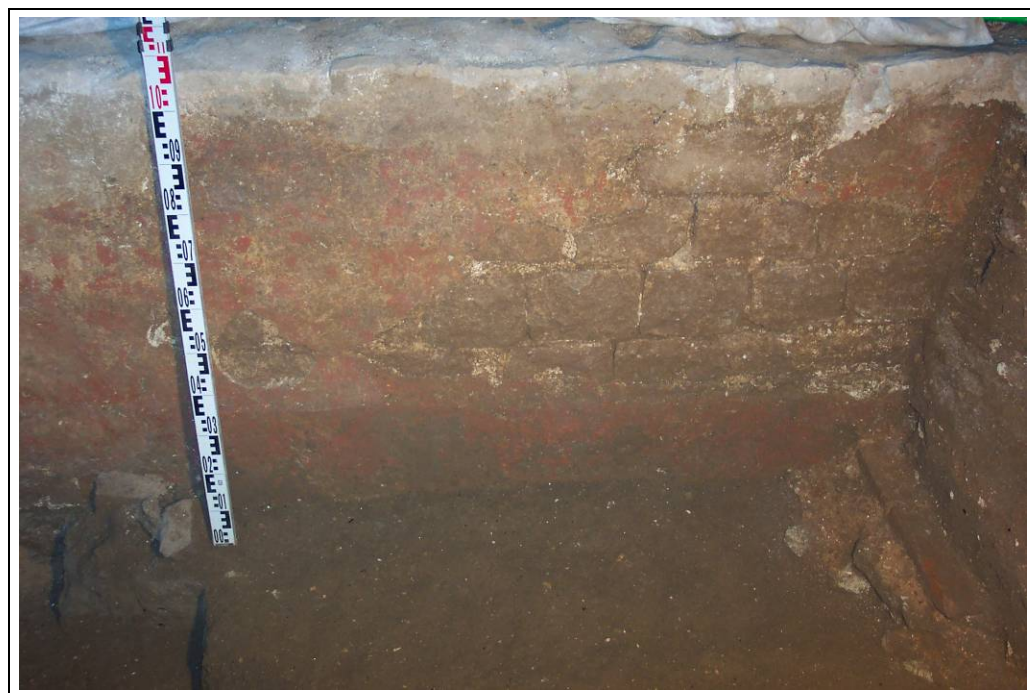
Foto 145: Àmbit 6. Alçat del mur 1054
